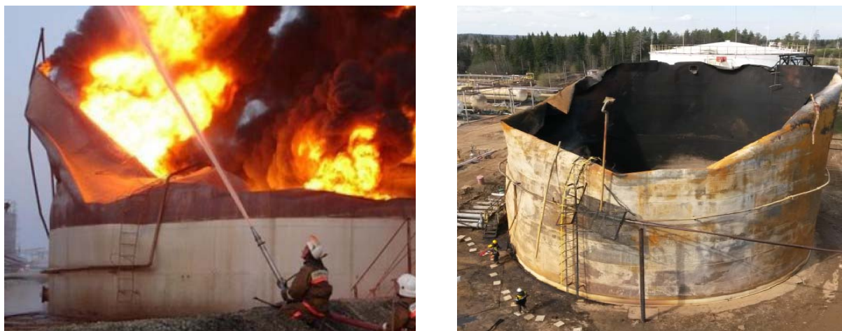
Рисунок 1 – Примеры разрушений РВС из-за разгерметизации
